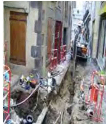
Chantier de renouvellement
